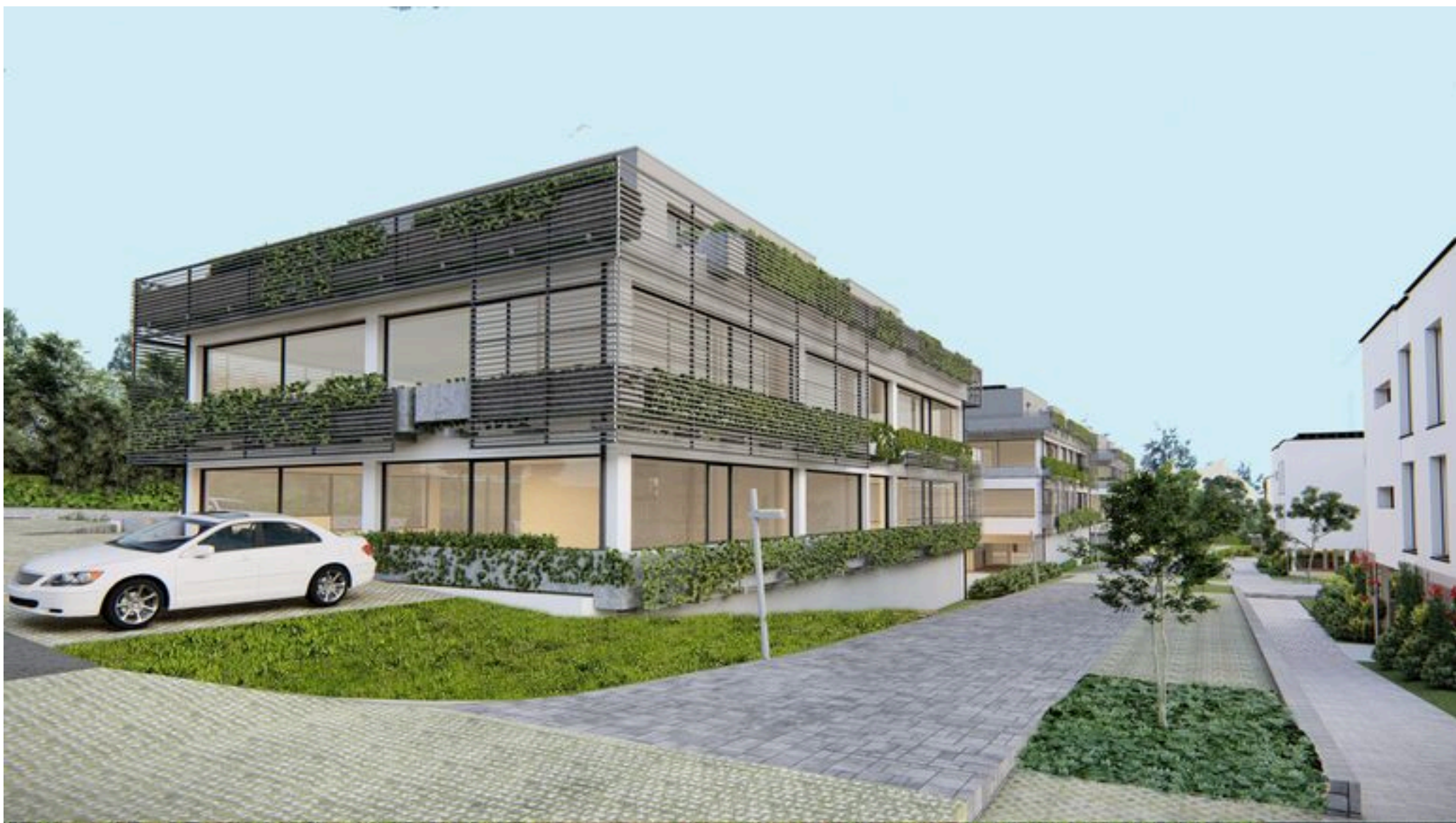
Immosol | Le Mont | Surfaces Commerciales
